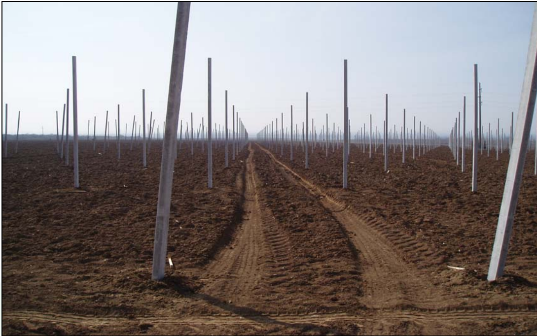
Postavljeni stubovi za protivgradnu mrežu
